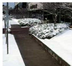
przykład wykonanej i funkcjonującej instalacji pod nawierzchnią schodów i chodnika
