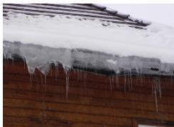
brak ogrzewania systemu rynnowego
